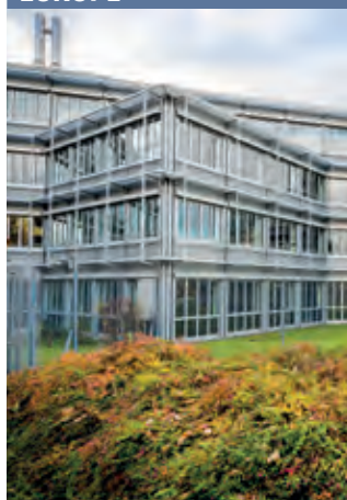
Kelsterbach Data Centre
